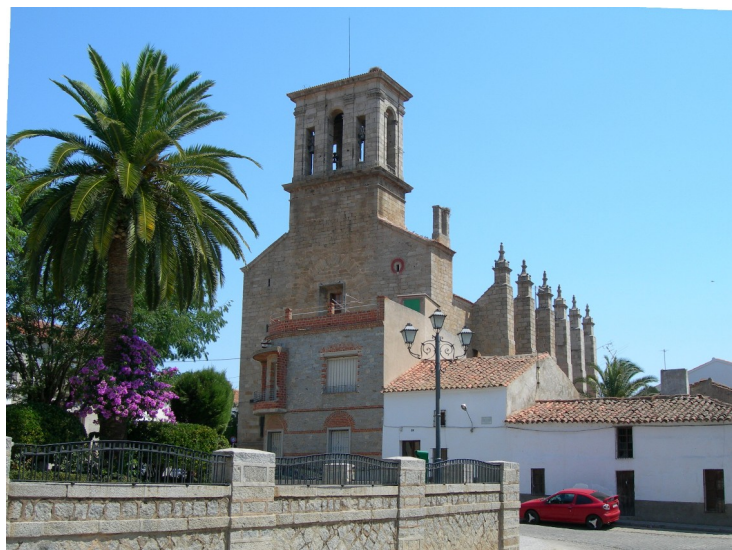
La Iglesia Parroquial de Santiago, hoy. Nótese la diferencia de altura del tejado en el lateral derecho, tras el derrumbe de 1948 y la reconstrucción del templo, entre 1960-1967, que no le devolvió la altura de la nave ni el esplendor interior que tuvo en el pasado.
