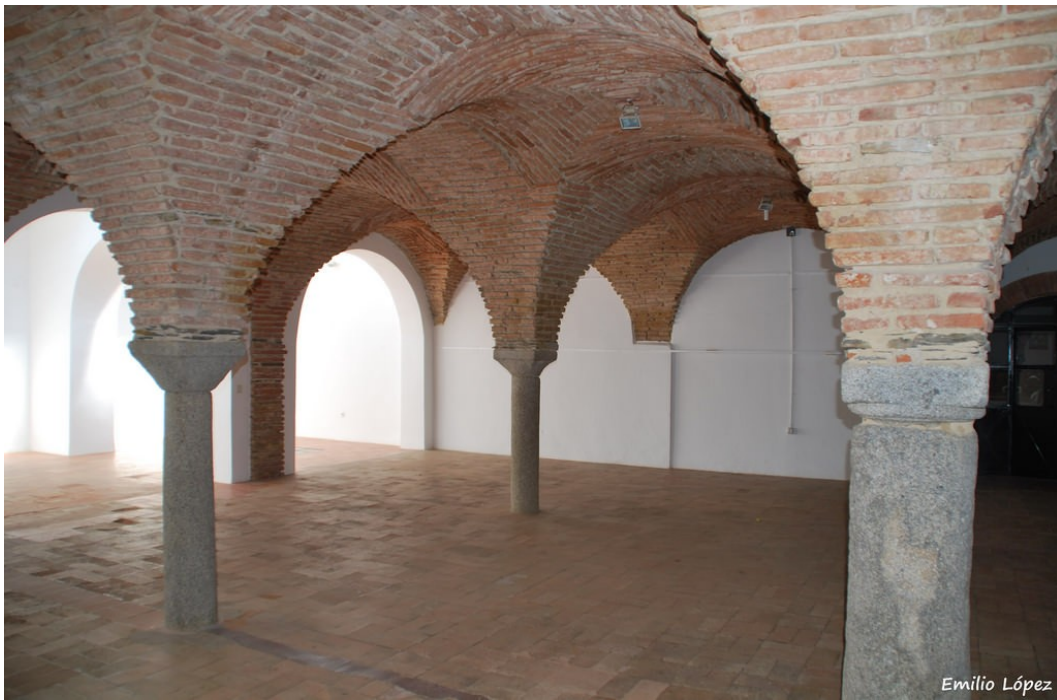
Interior del Pósito Municipal, en su origen como almacén de grano del Concejo de Belalcázar (S.XV). Destacan sus originales bóvedas de ladrillo puestos de canto, sobre recias columnas de granito a media altura. Cuenta con una zona anexa, construida en el S.XVI, a la cual se accede por una puerta con arco de medio punto, hecha en granito. Ha tenido diversos usos (mercado de abastos, escuela, cárcel, etc). Hoy día se destina a eventos culturales.
