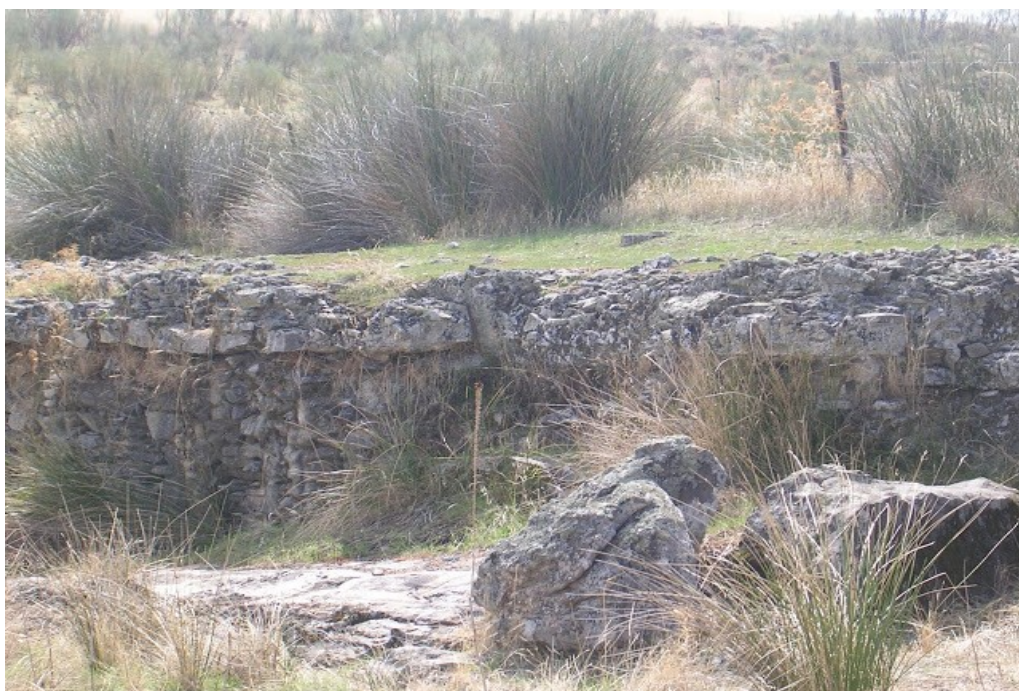
Foto de la presa romana del arroyo de Torrotejada, en la finca de Rebasco, al noreste de la localidad de Belalcázar. Presenta la peculiaridad de ser presa y tener una calzada romana sobre ella. Cuenta con varios aliviaderos de agua y tajamares para repartir el empuje de las aguas, sobre todo en épocas de crecidas. La zona presenta numerosos restos de época romana.
